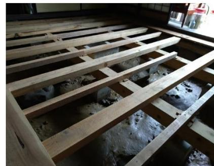
大雨により土砂が外壁部に50cm位まで堆積している状況でした。室内はほとんど床上、床下浸水したとの事で、床板を捲ると1cmくらいの土砂が堆積。
