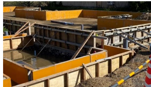
型枠の補強材
